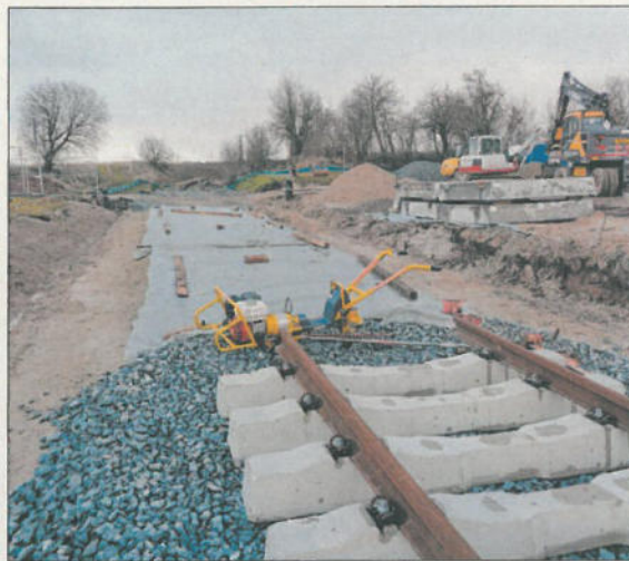
Die Arbeiten am umstrittenen Bahnübergang haben schon begonnen: Die Schienen sind ausgebaut, der Untergrund wird verdichtet. F.: Peter Sennfelder
