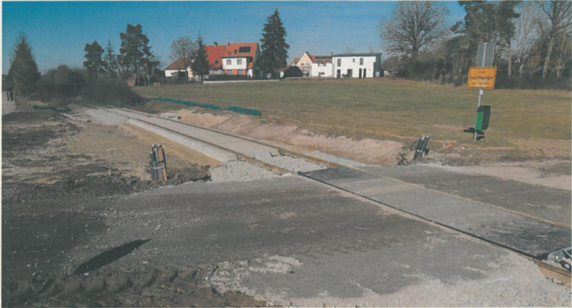
Noch dient der alte Bahnübergang (vorne rechts) landwirtschaftlichen Fahrzeugen, Radfahrern und Fußgängern zum Queren der Gleise. Später soll die Westtangente dann wenige Meter nördlich davon über die Schienen führen – und zwar dort, wo der neue Übergang bereits betoniert ist. Foto: Peter Zumach
