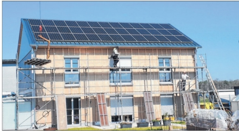
Photovoltaikanlagen auf dem Dach und an der Fassade sollen im Haus von Birgit und Willi Krauss genug Strom für Haushalt, Heizung, Kühlung und Mobilität liefern. Foto: Willi Krauss
