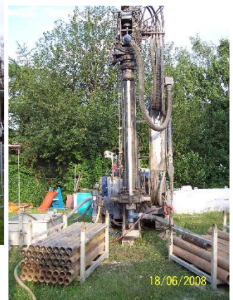
Bohrung der Erdwärmesonden
